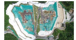
特定廃棄物埋立処分場
