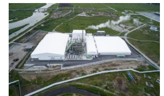
浪江町 仮設焼却施設
