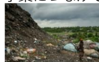
モザンビークの最終処分場での大雨による崩落事故
