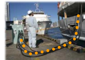
電力供給設備
