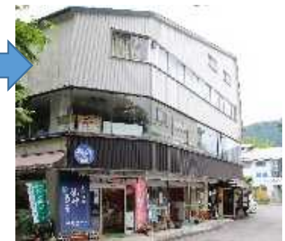
老朽化した外壁を修繕
