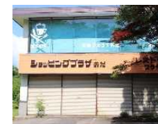
撤去予定の土産物店
