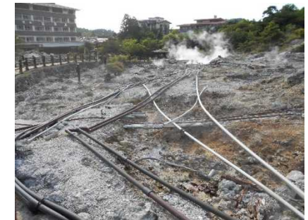
景観を損ねている温泉配管（現在の様子）【雲仙温泉】
