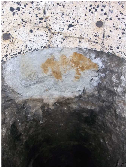
①煙突用石綿断熱材
