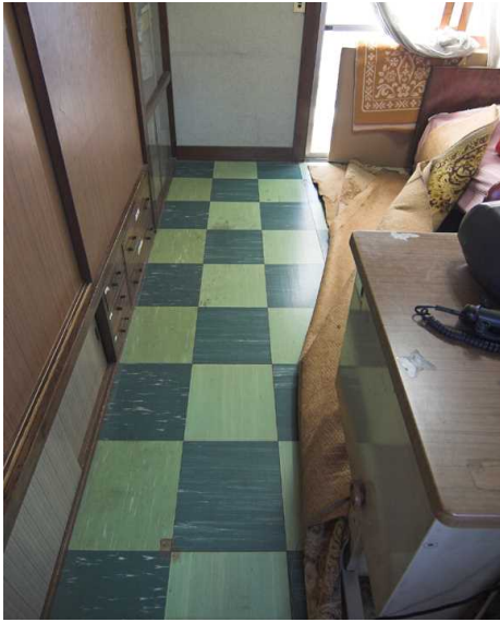
①石綿含有ビニル床タイル
