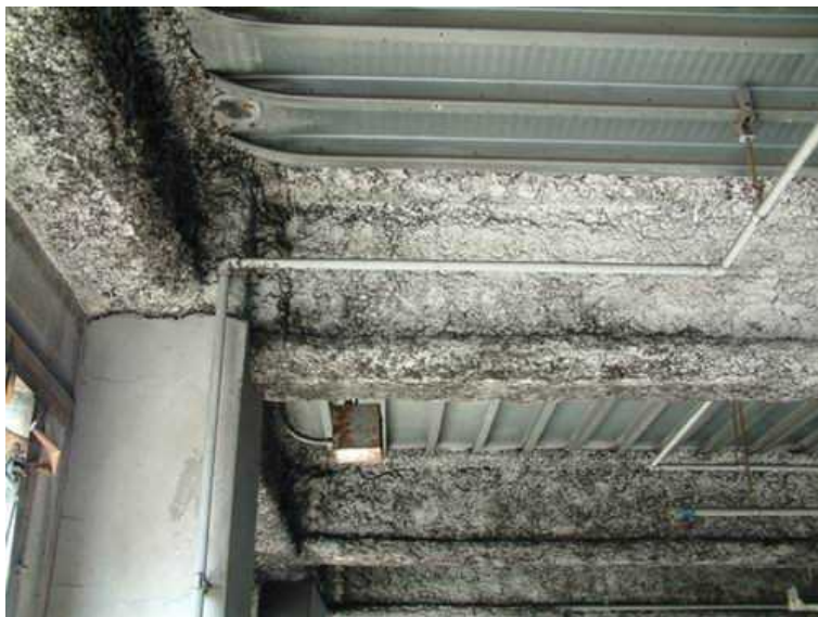
②石綿含有吹付けロックウール
