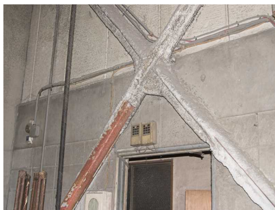
レベル1: 吹付け石綿(クリソタイル)
