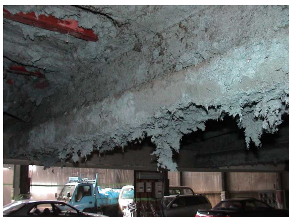
レベル1: 吹付け石綿(クロシドライト)
