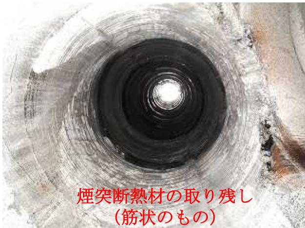
煙突断熱材の取り残し
