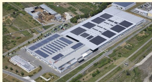
工場の屋根置き太陽光発電
