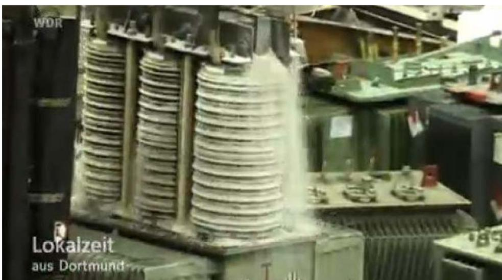
この写真によると、能動部分が、PCB で汚染されたバインダーを前もって吸い取ることなく、また、特別な受け止めの対策もなく、引き抜かれる様子をはっきり分かる。バインダーは筐体の脇を通過してホールの床に落下している。
