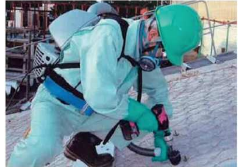
粉じん回収（高性能真空掃除機）
