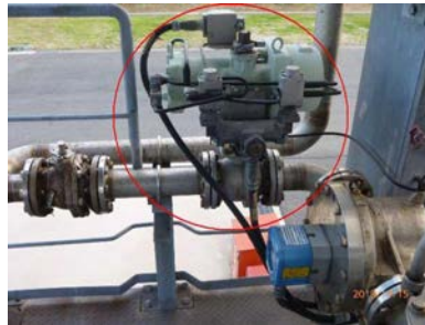
出荷設備遮断弁
