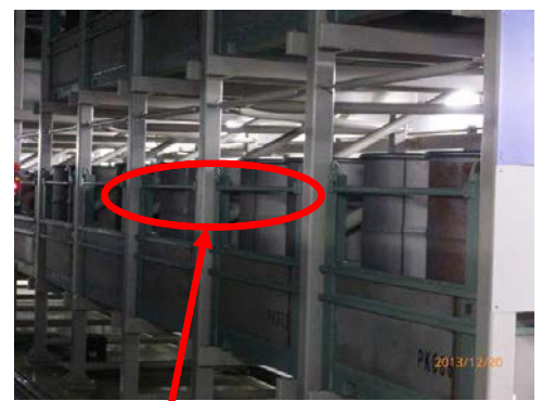
転倒防止柵設置(ドラム缶)
