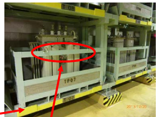
転倒防止柵設置(トランス)
