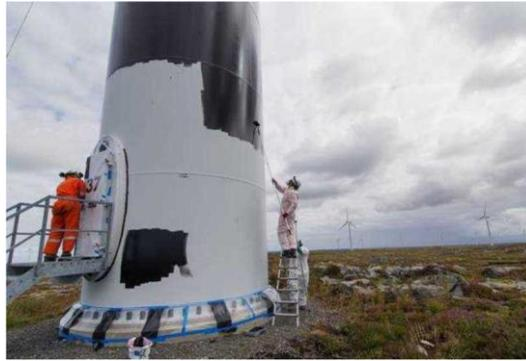
図-74 ノルウェーにおける風車タワー下部への彩色の事例
