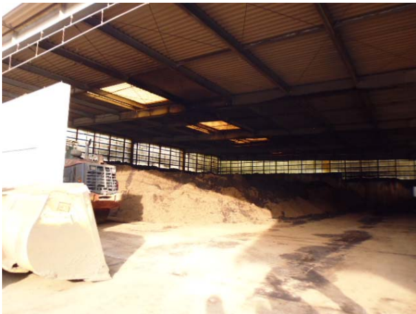
写真5 脱臭棟（生物脱臭槽）
