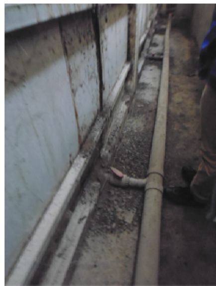
写真2 床面のエアレーション (発酵槽外側)
