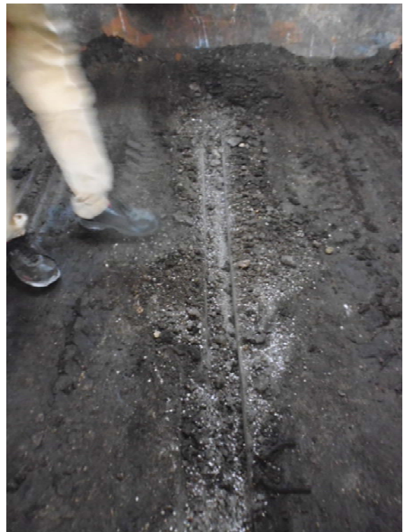
写真6 床面に埋設している通気口
