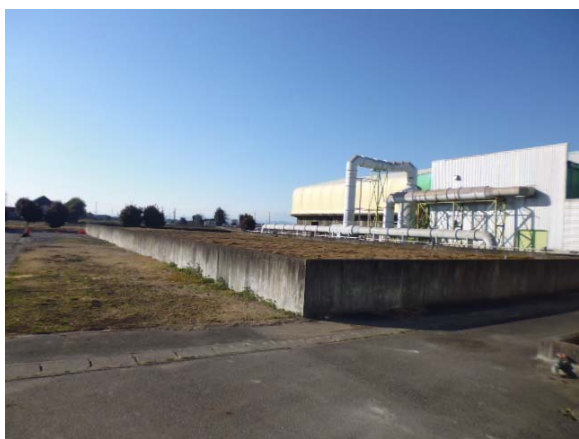
写真6 生物脱臭槽
