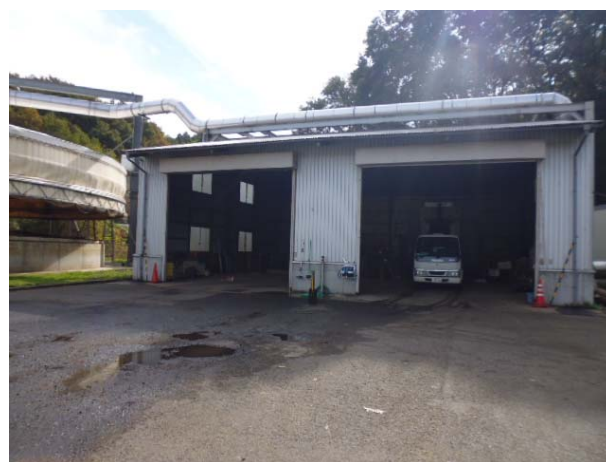
写真 5 原料投入棟 (上部から吸引して脱臭処理)
