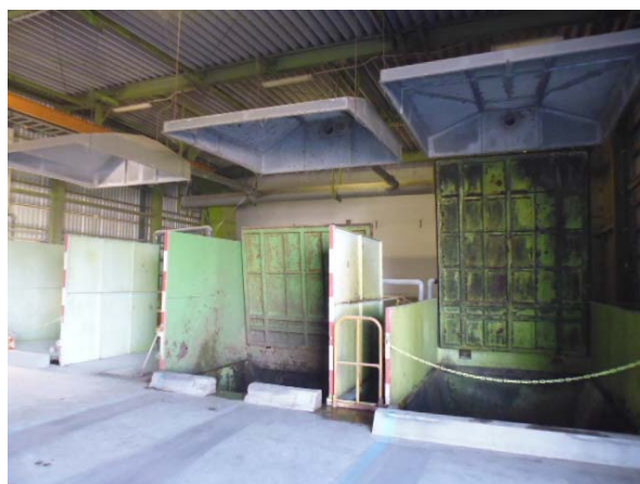
写真4 原料投入口と吸引フード
