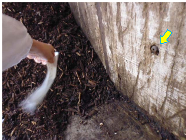
写真3 壁面からの加圧空気孔（右上矢印）
