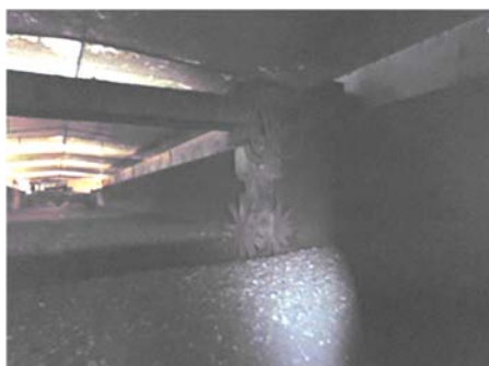
写真4 発酵槽の内部
