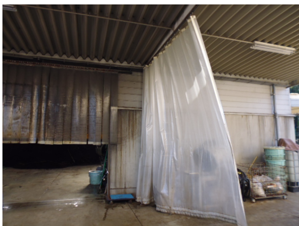
写真4 堆肥棟の搬入口
