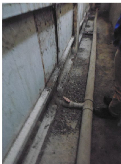
写真2 床面のエアレーション (発酵槽外側)
