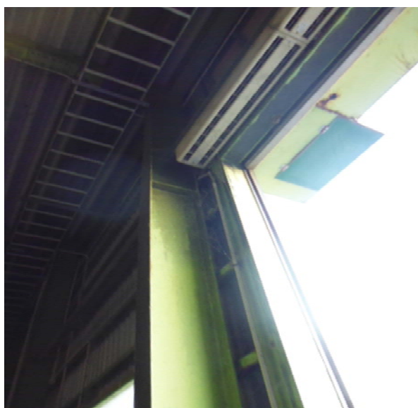
写真5 原料投入棟の搬入口のエアーカーテン
