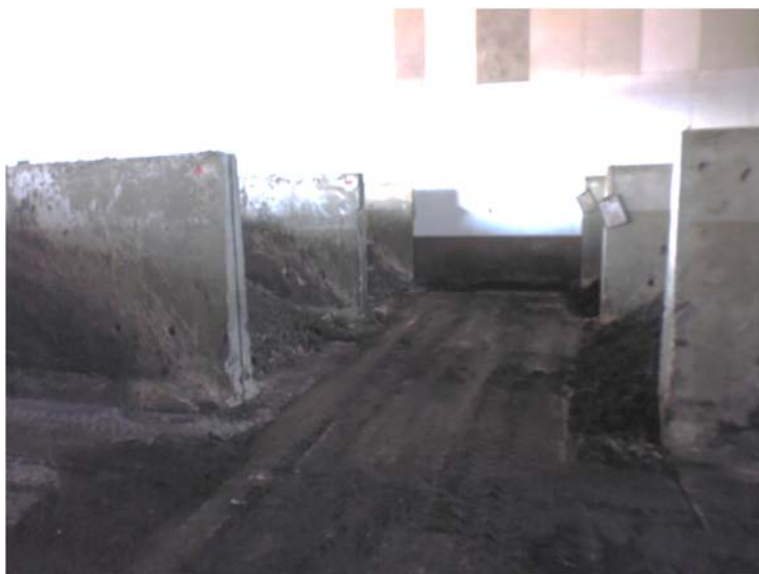
写真1 堆肥棟内の6つの発酵槽
