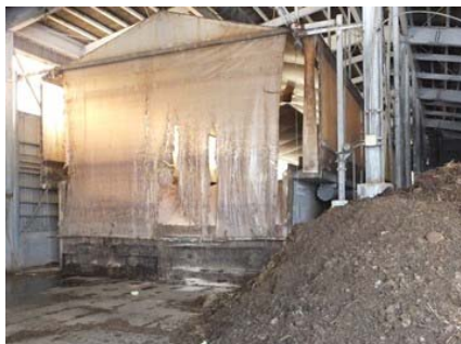
写真5 一次発酵槽の入口側（投入口）
