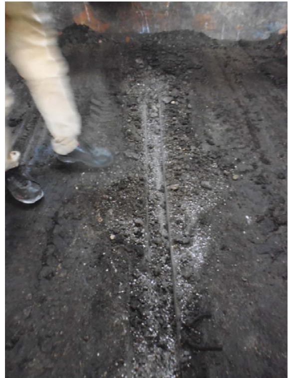
写真6 床面に埋設している通気口
