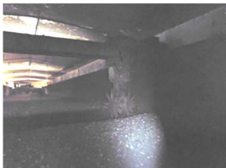
写真4 発酵槽の内部
