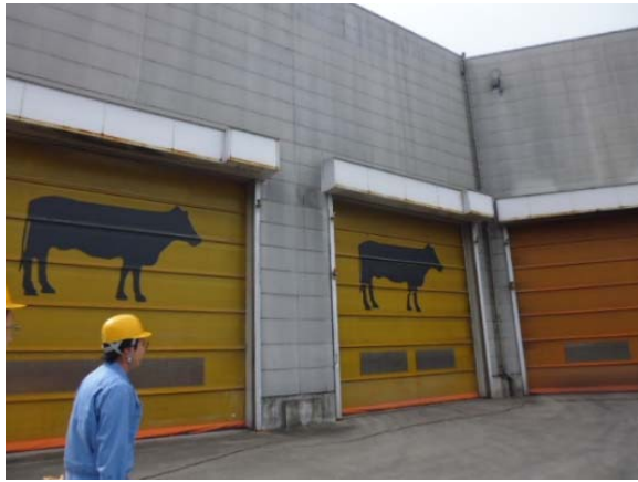
写真5 畜ふんボイラー原料投入棟
