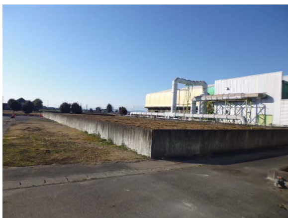
写真6 生物脱臭槽
