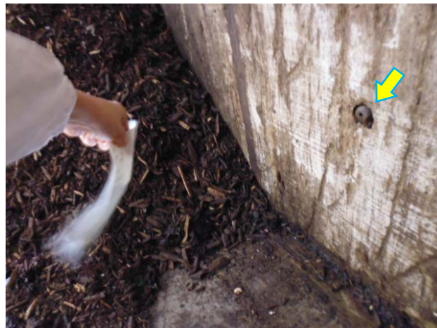
写真3 壁面からの加圧空気孔（右上矢印）
