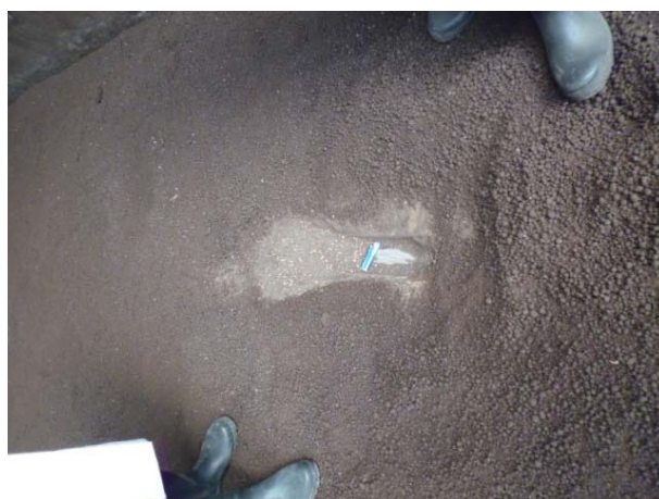
写真3 床面の通気口（一次発酵槽）
