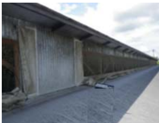
脱臭装置の設置前
