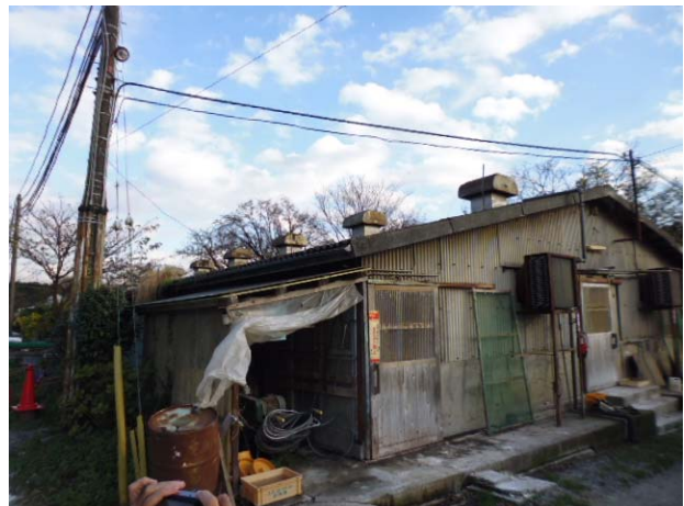
写真2 豚舎の屋根上の換気扇は停止中
