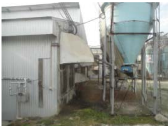
脱臭装置の設置前
