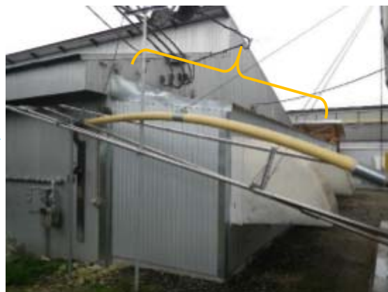
脱臭装置の設置後
