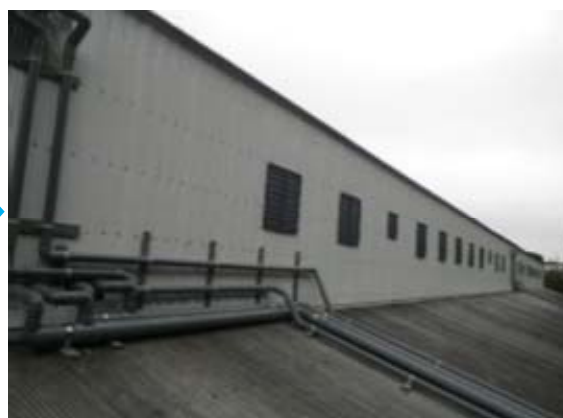
脱臭装置の設置後
