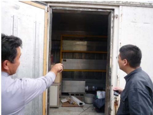
写真1 オゾン噴霧装置
