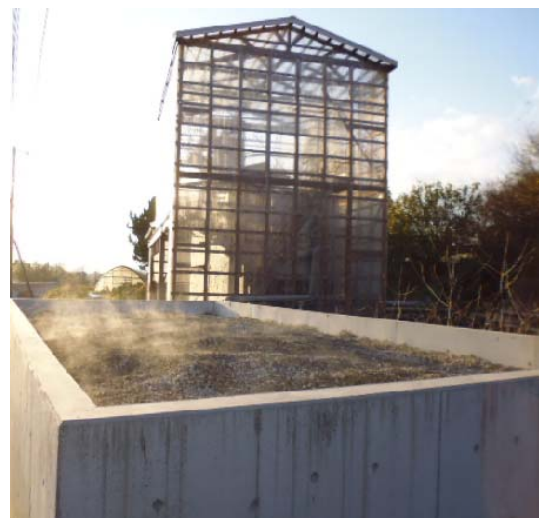
写真4 密閉縦型発酵装置用の軽石脱臭装置
