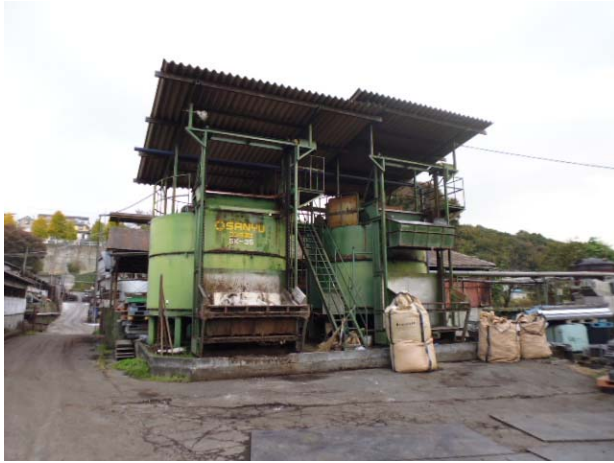
写真7 密閉縦型発酵装置 (S社2基)
