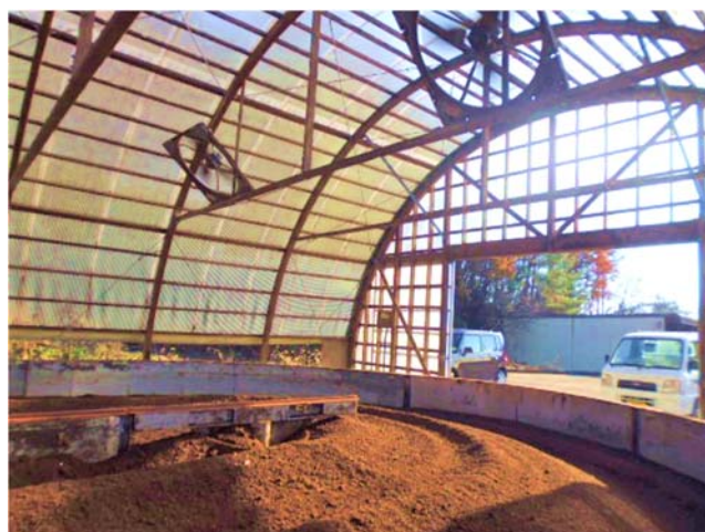
写真5 堆肥センターの換気扇（入口側から）
