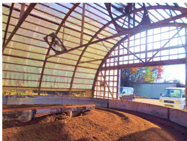
写真5 堆肥センターの換気扇（入口側から）
