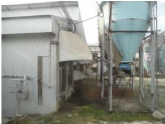
脱臭装置の設置前
