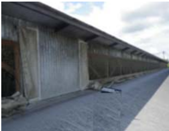
脱臭装置の設置前
