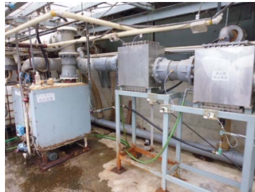
写真8 アンモニア回収装置と熱交換器
