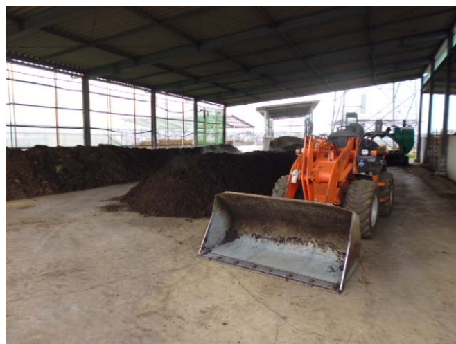
写真5 堆積用の重機
