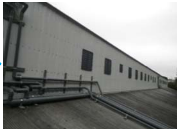
脱臭装置の設置後
