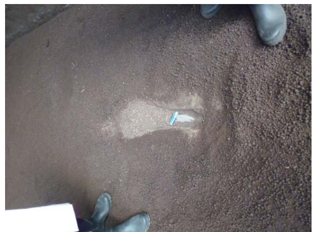
写真3 床面の通気口（一次発酵槽）
