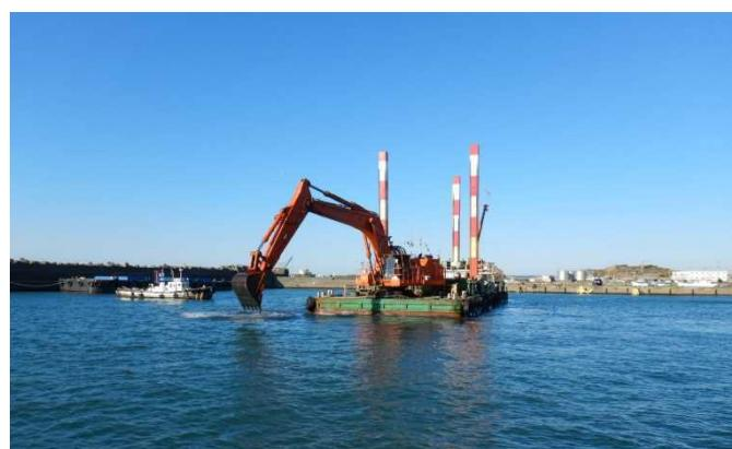
写真-1 しゅんせつ及び土運船への積み込み状況
