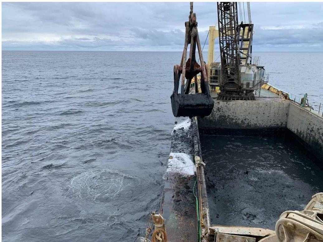
写真-5 ガット船によるしゅんせつ土砂排出状況
