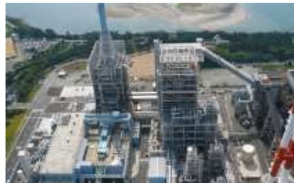
石炭ガス化複合発電プラント (IGCC)
