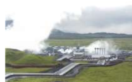
地熱発電プラント
