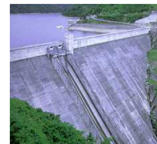
ダム建設での大量利用
