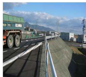
路盤材施工事例
