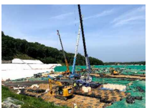
特定廃棄物埋立処分施設
