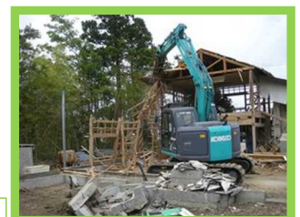
被災家屋等の解体
