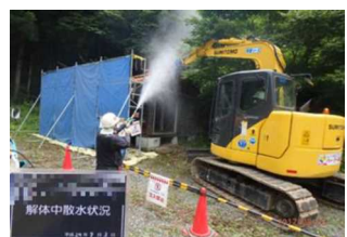
被災家屋等の解体の様子
