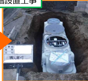
合併浄化槽設置
