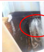
浄化槽の劣化(左:鋼管製バルブの腐食、右:塩ビ管の破損)
