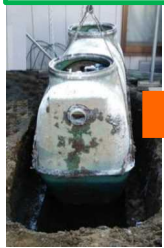
単独浄化槽撤去
