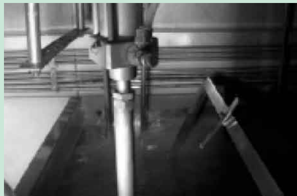
冷却効果改善(装置内部)
