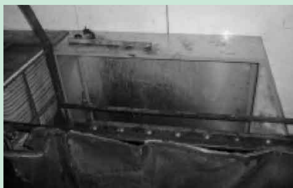
装置出口の局所排気の改善(横引き)
