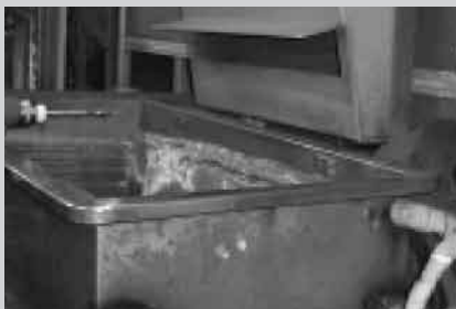
手動2槽式 乾燥装置の 局所排気口
