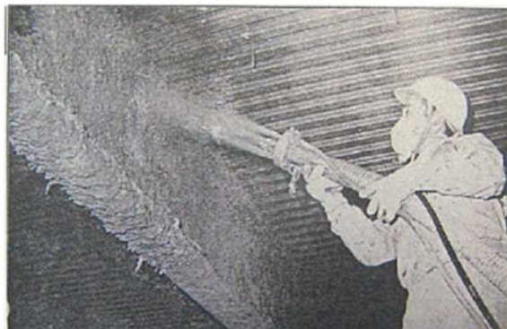
石綿を含む耐火被覆の吹付作業
