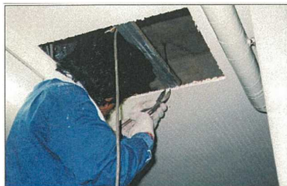
設備工事に伴う石綿ケイカル板開削
