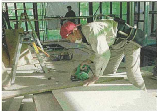
石綿ケイカル板切断作業
