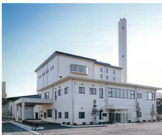
写真 3-2-1 本事業に使用するごみ焼却施設の全景写真
