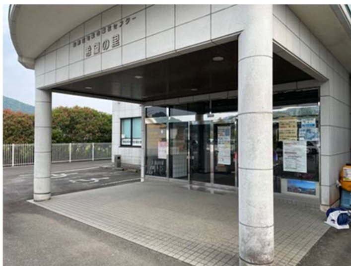
写真 3-2-2 本事業に使用する熱利用施設の全景写真
