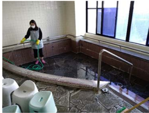
写真 3-2-3 温浴施設の内観(浴槽)
