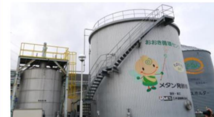
バイオガスプラント全景
