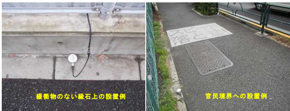
図 4-2 振動ピックアップの設置例
