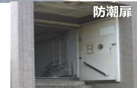
地下鉄出入口の浸水対策
