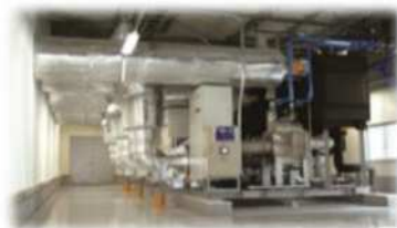
空気冷凍システムによる 中央方式冷凍冷蔵機器
