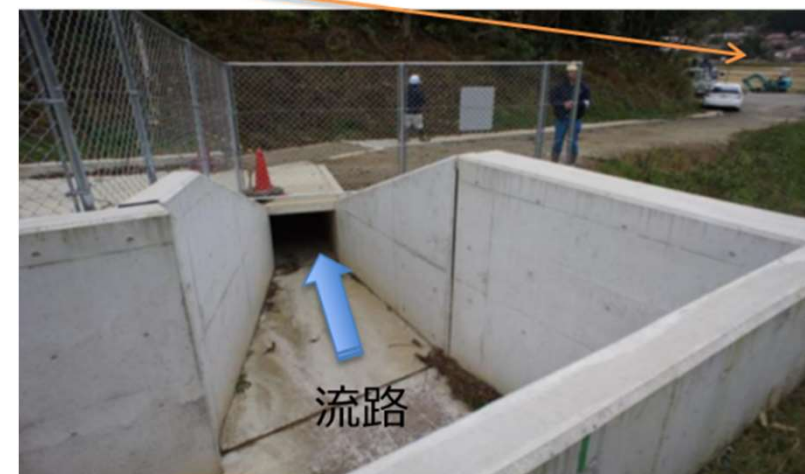
用水路の整備
