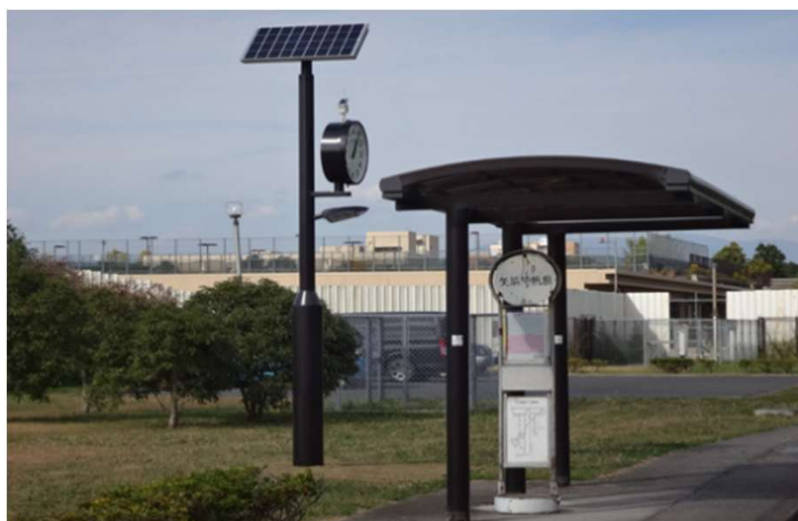
公園バス停に設置された太陽電池式の街灯・時計台
