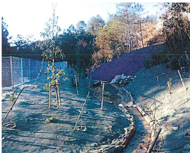
ビオトープ及び水路の設置
