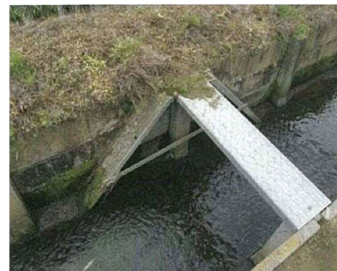
小動物移動機能付き水路の設置
