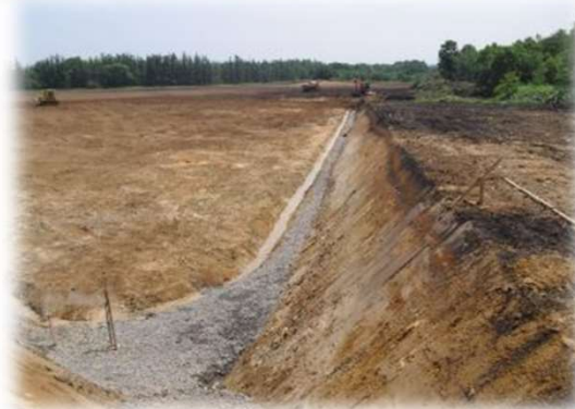
処理後(暗渠管設置)
