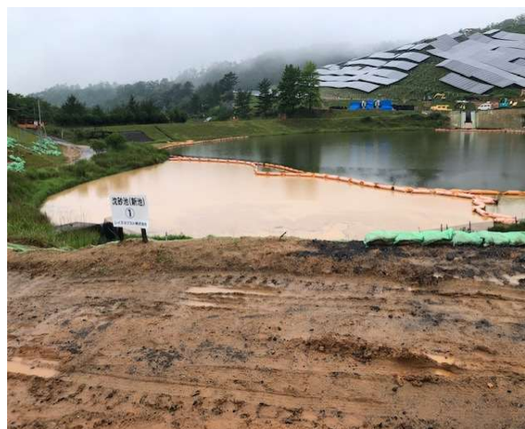
シルトフェンスを二重に設置
