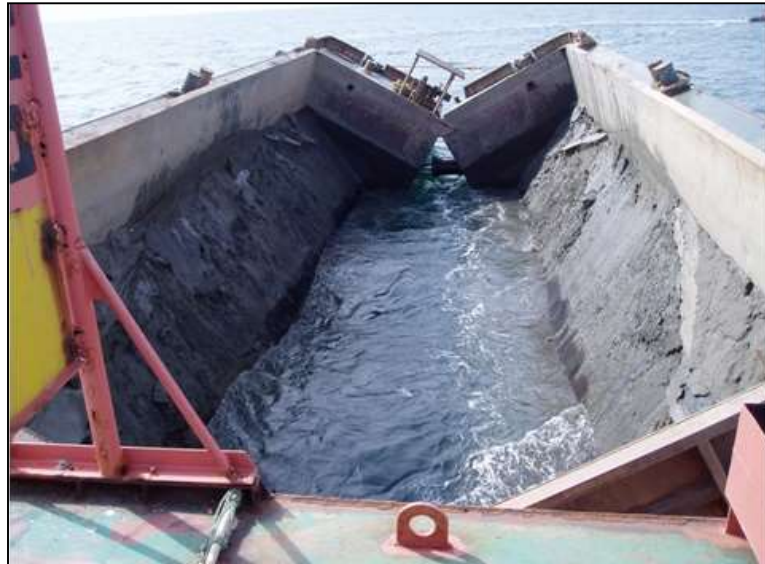
図2 排出中(土運船全開時)
