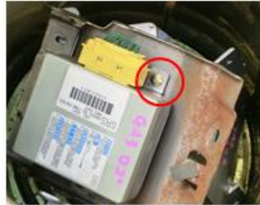
写真② 赤丸部分がリベット接合
