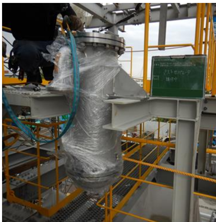
図 4-3-2 ガス精製装置の据付状況 2
