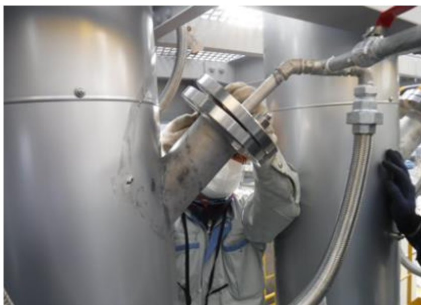
図 4-4-2 急冷塔スプレーノズルの流量調整試験の状況 1
