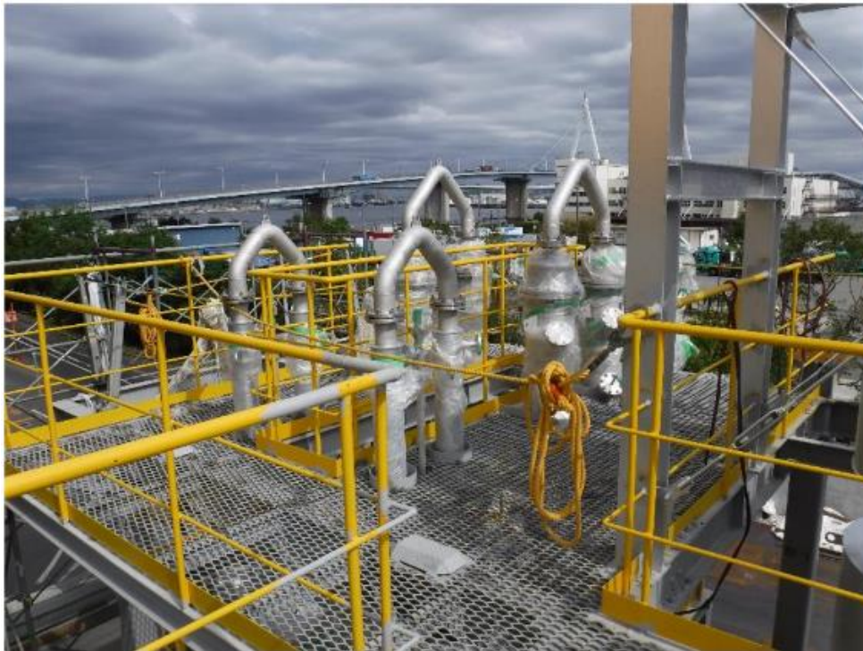
図 4-3-5 ガス精製装置の据付状況 5
