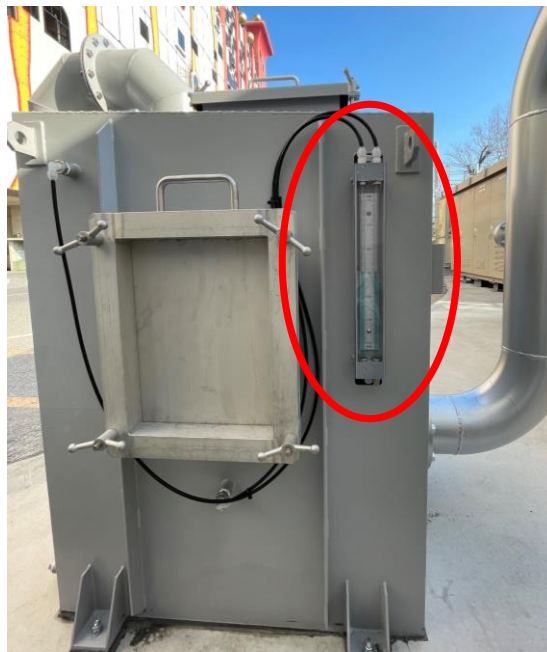
図 5-8-8 脱臭装置の差圧計設置状況
