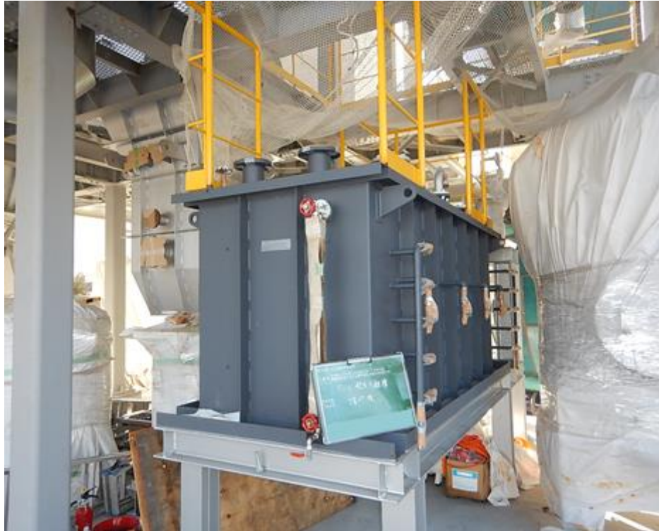
図 4-3-3 ガス精製装置の据付状況 3
