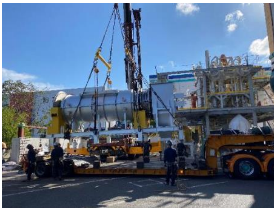
図 3-4-1 熱分解ガス化改質炉の据付状況 1
