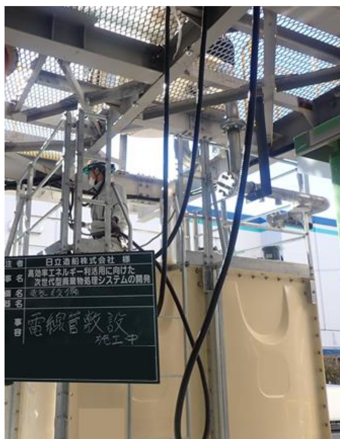
図 5-4-17 電線管敷設
