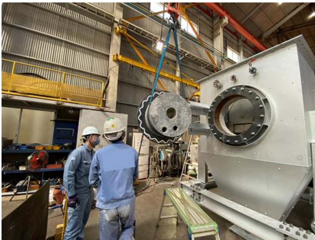
図 3-3-6 チャー貯留槽
