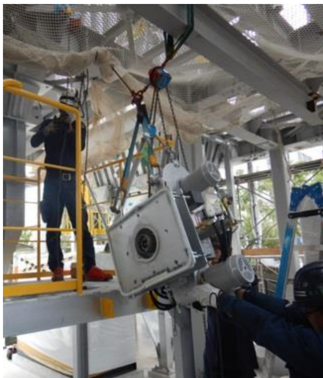
図 5-4-10 燃焼炉用灯油バーナ
