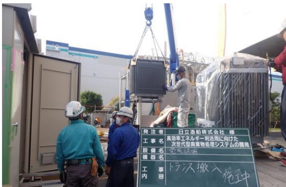
図 5-4-15 トランス搬入据付
