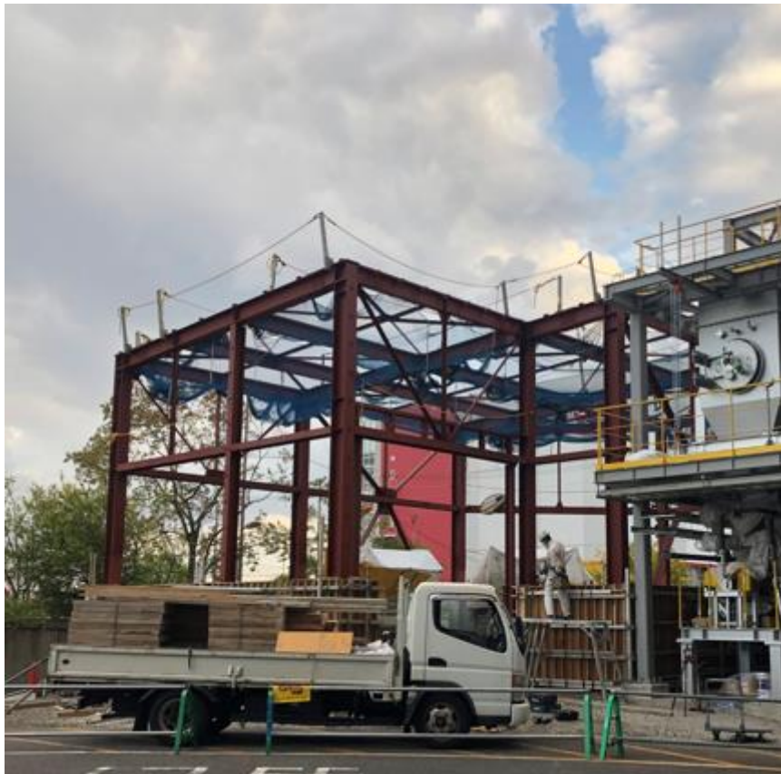
図 5-4-23 受入れごみ貯留ヤード基礎工事 2
