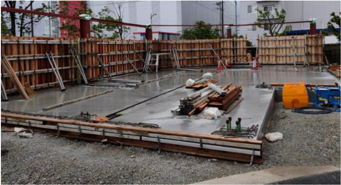
図 5-4-22 受入れごみ貯留ヤード基礎工事 1
