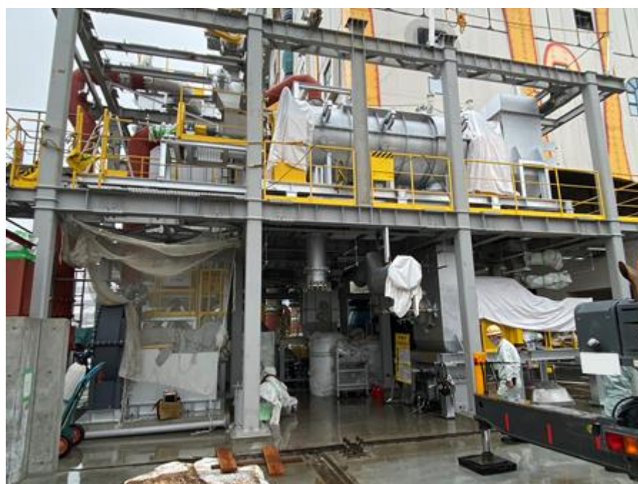
図 3-4-2 熱分解ガス化改質炉の据付状況 2
