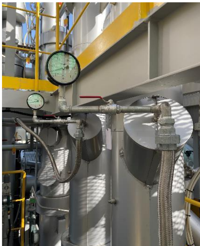
図 5-6-8 運転時の吸収塔の水の噴霧状況
