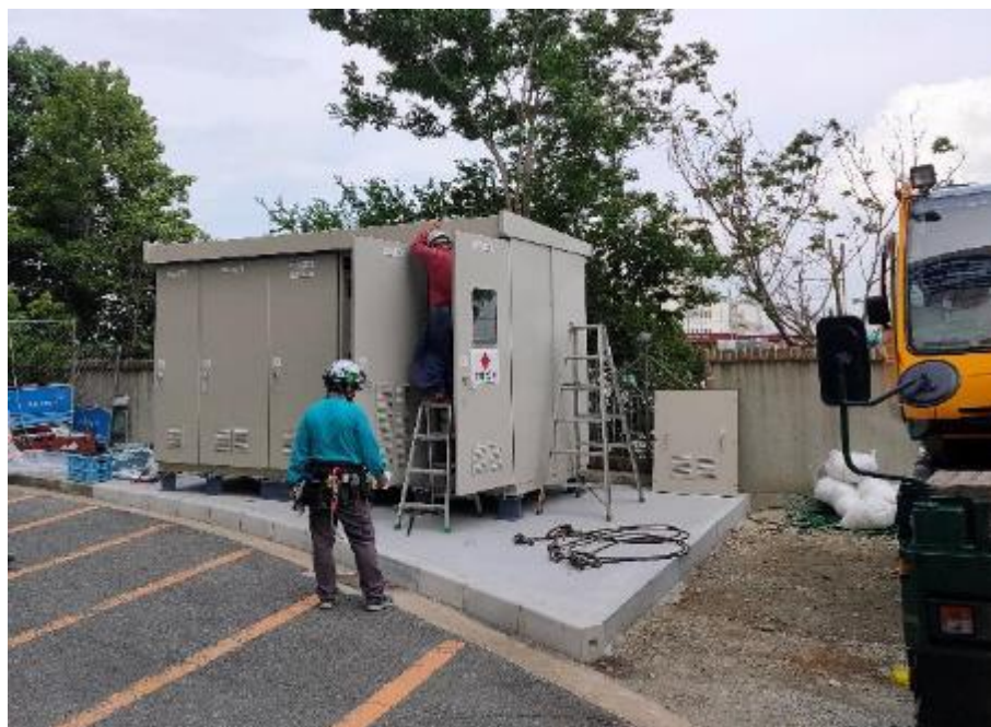
図 5-4-14 動力盤据付
