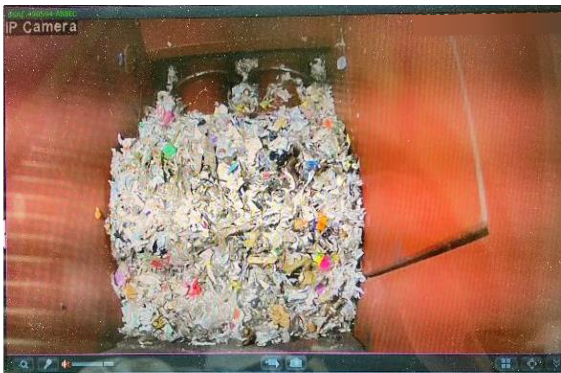
図 5-6-5 熱分解ガス化改質炉への給じんの様子
