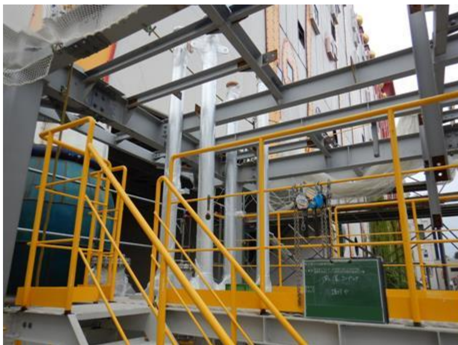
図 4-3-1 ガス精製装置の据付状況 1
