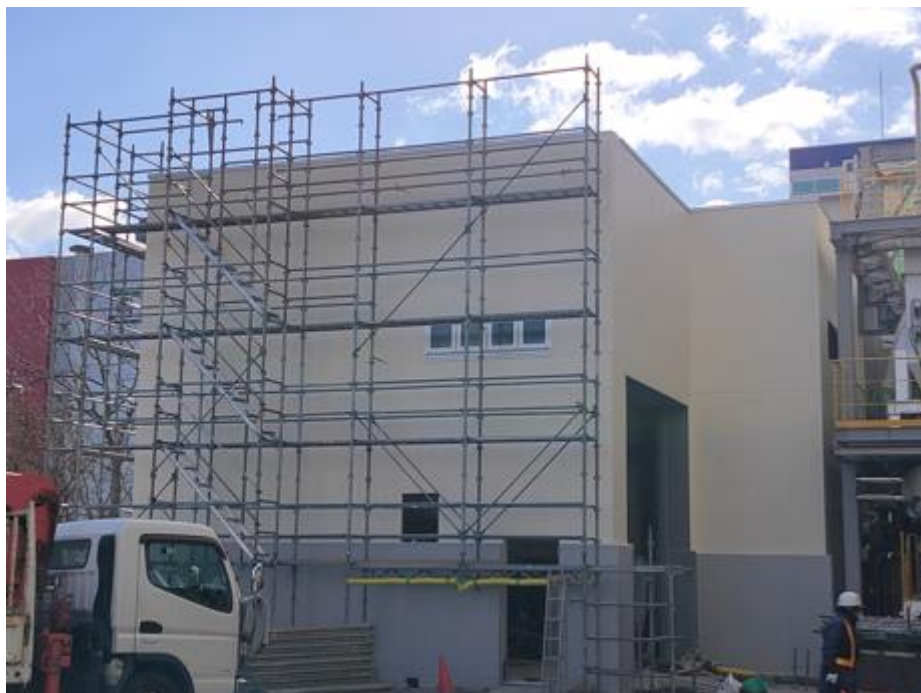
図 5-4-24 受入れごみ貯留ヤード建屋工事
