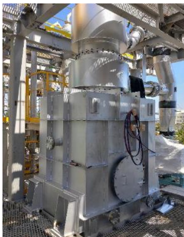
图 5-4-9 燃烧炉
