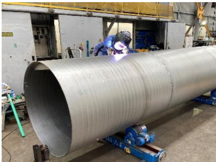
図 3-3-2 熱分解ガス化改質炉の円筒部分
