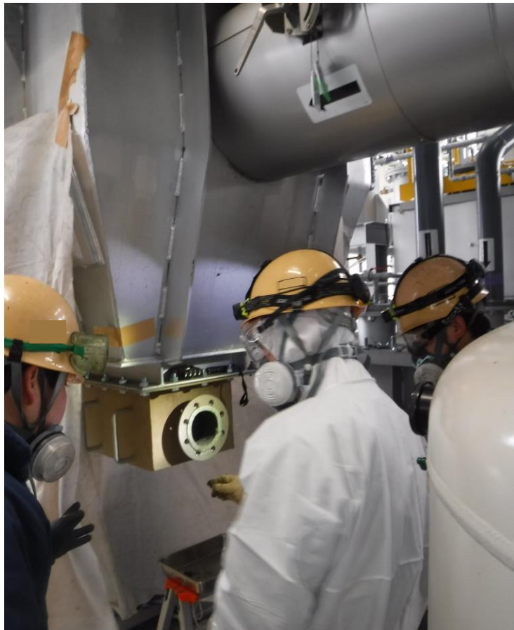
図 5-6-11 運転後の内部点検の様子
