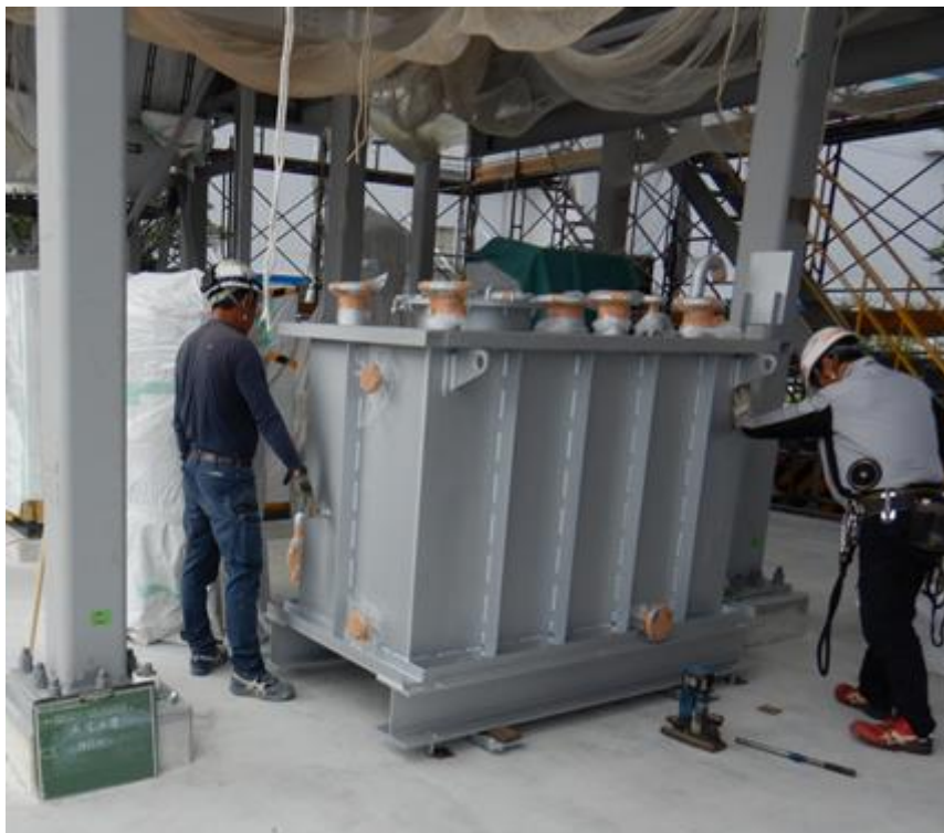
図 4-3-4 ガス精製装置の据付状況 4
