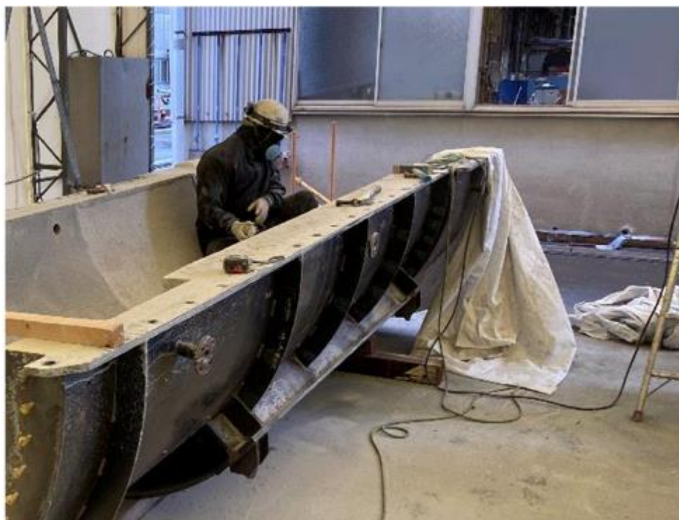
図 3-3-3 熱分解ガス化炉改質炉の外筒
