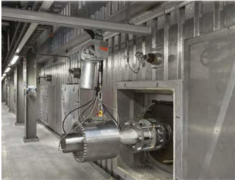
図 3-21 圧力波式スートブロワ設置イメージ
