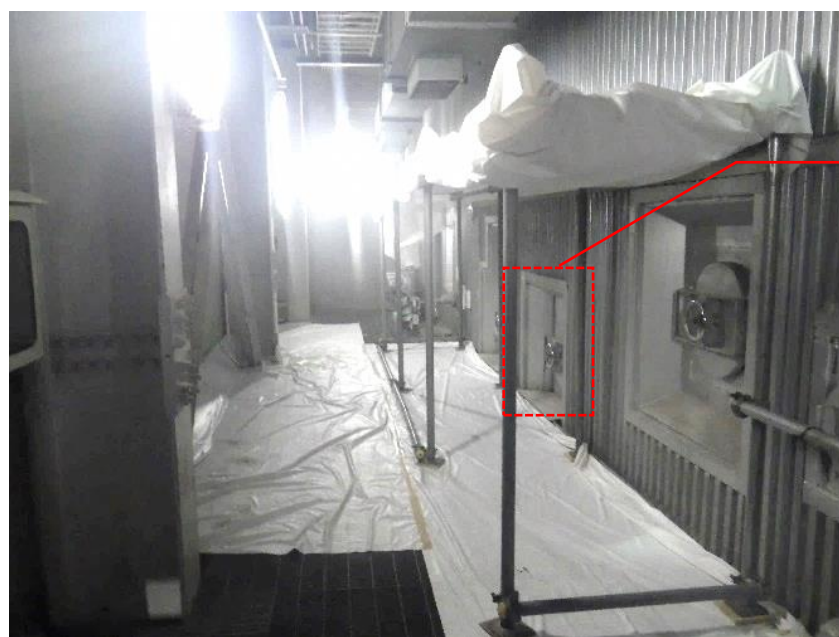
図 3-18 圧力波式スートブロワ位置
