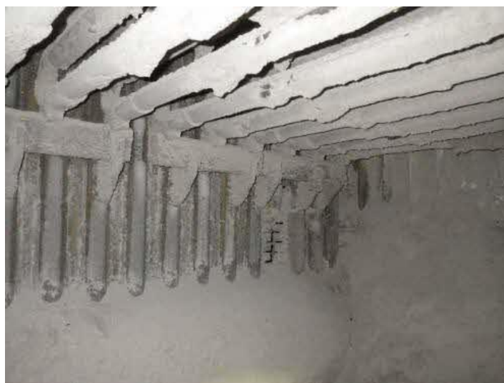
図 3-1 1 号炉スーパーヒーター下部
