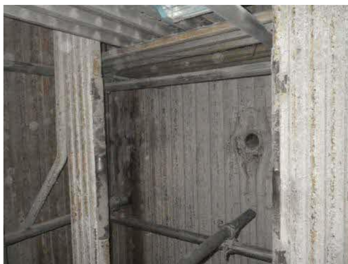
図 3-2 1 号炉#2 スートブロワ周辺水管
