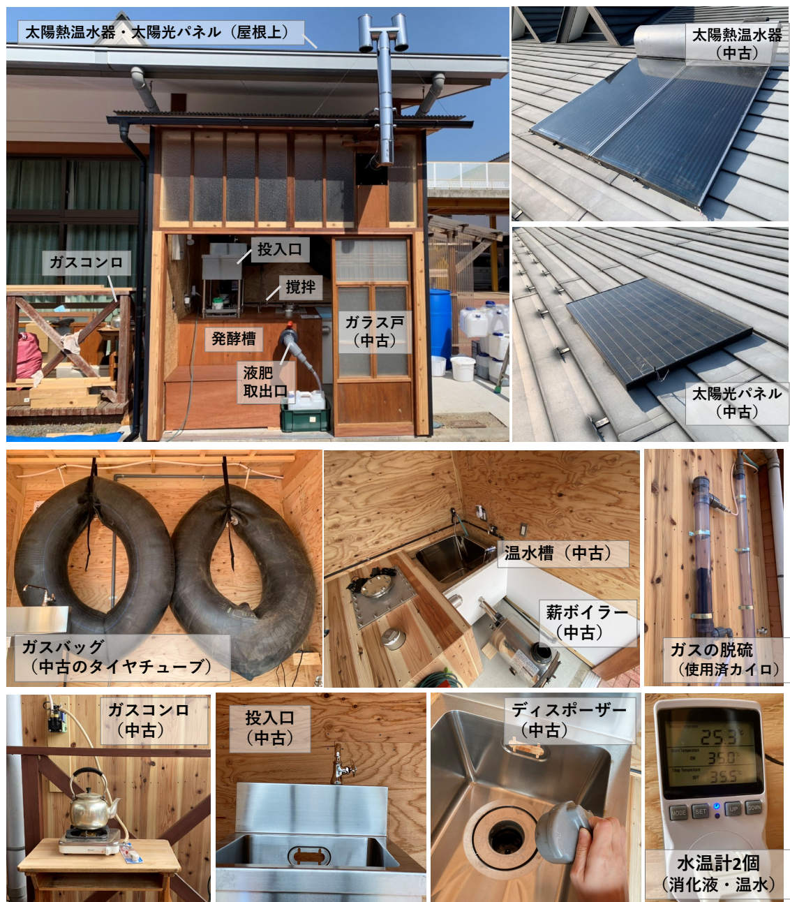
図 35 バイオガスプラントの機能
