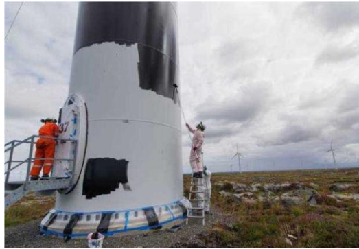
図－64 ノルウェーにおける風車タワー下部への彩色の事例
