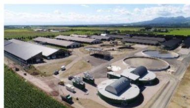
バイオガスプラント
