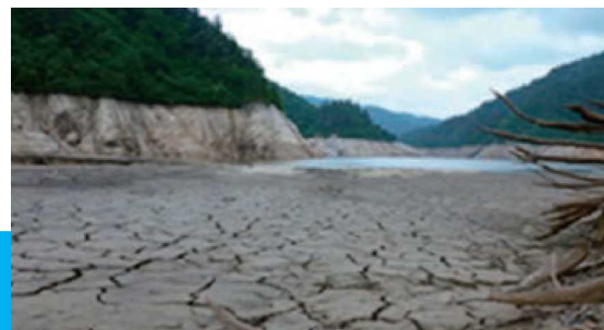
平成28年の渇水時の矢木沢ダム（群馬県） 出典：「平成29年度水循環施策」
