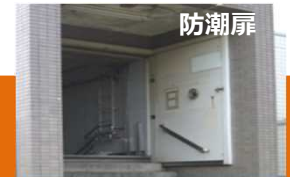
地下鉄出入口の浸水対策
