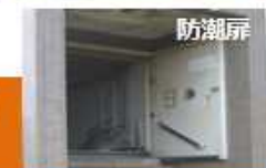
地下鉄出入口の浸水対策
