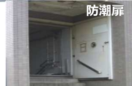
地下鉄出入口の浸水対策
