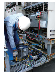
スーパーマーケット冷蔵ショーケース(室外機)からのフロン類冷媒回収の様子
