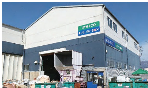
倉庫だった施設を改装して作業場にした
