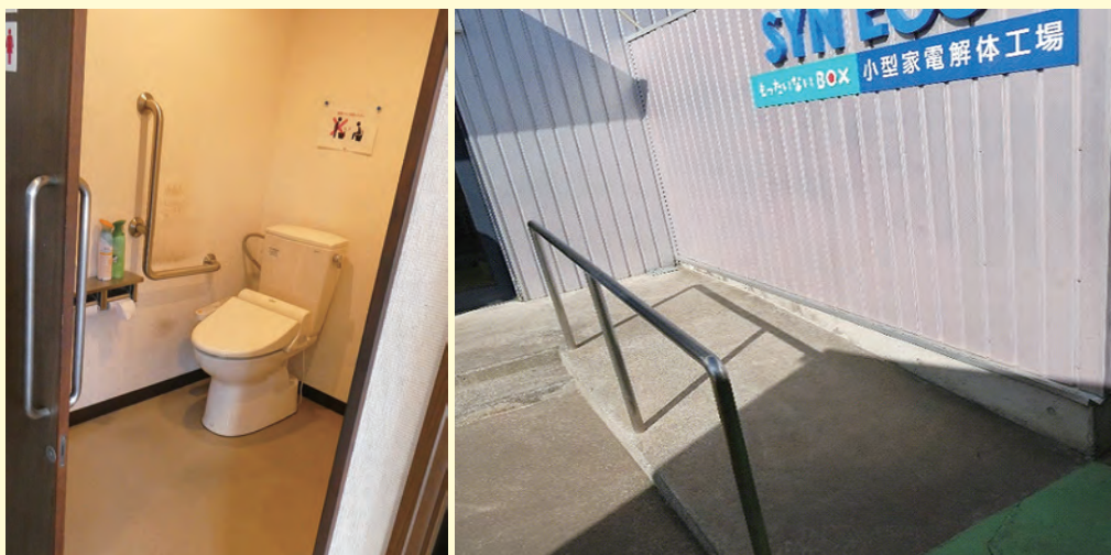
車椅子でも移動できるようにスロープの設置（右）や、トイレのバリアフリー化（左）を図る
