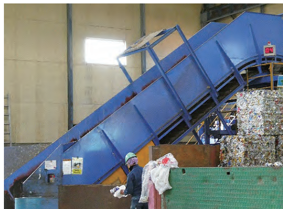
ペットボトルを圧縮機に送るコンベア。人がコンベア内に落ちた時などにセンサーによりコンベアが自動停止する
