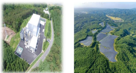
十文字チキンカンパー バイオマス発電所
