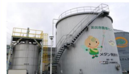
バイオガスプラント全景
