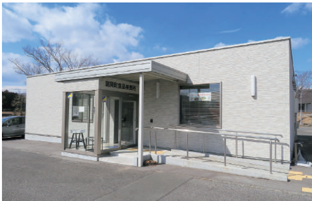
富岡町食品検査所（外観）
