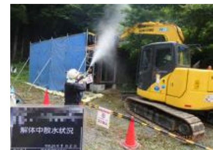
被災家屋等の解体の様子
