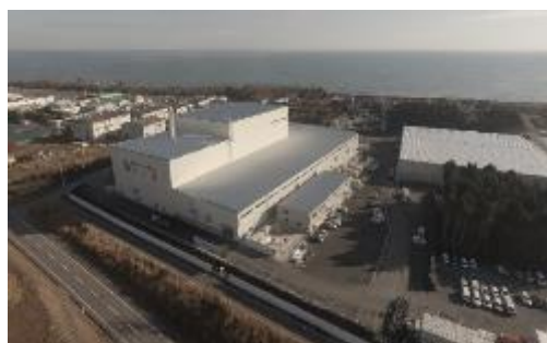
大熊町の仮設焼却施設(2017年12月)
