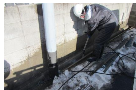
●側溝の汚泥の除去 (提供) 福島市
