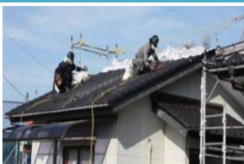
●建物の屋根等の洗浄
