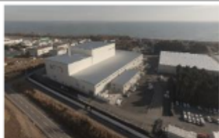
大熊町の仮設焼却施設(2017年12月)
