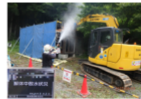
被災家屋等の解体の様子
