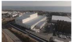
大熊町の仮設焼却施設(2017年12月)
