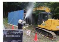
被災家屋等の解体の様子
